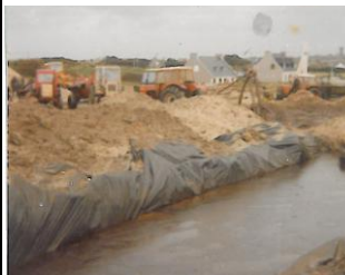
Fosse creusée dans la dune du Pouldu pour stocker le pétrole échoué sur les plages.
